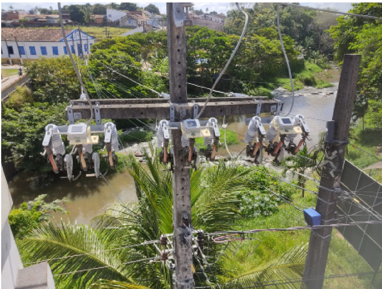
Figura 9. Sensores tipo 2 instalados em chaves fusíveis religadoras
